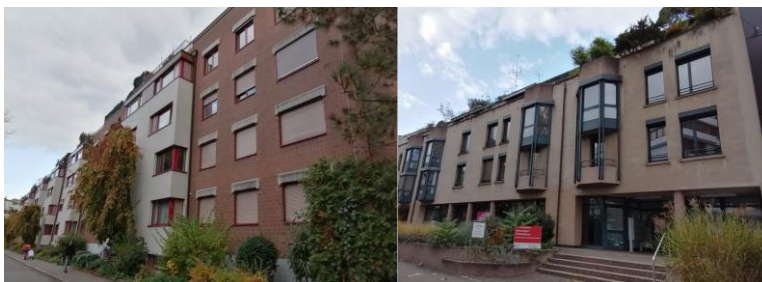
links: Überbauung Birsigstrasse 10 12 und Rümelinbachweg 15 17 19 21 23 25
